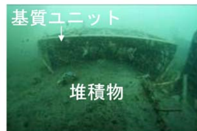
図5 地点Aにおける試験礁の埋没状況
