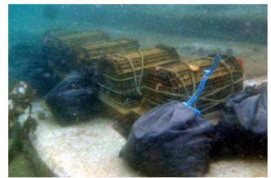
写真-7 土嚢袋での補強
