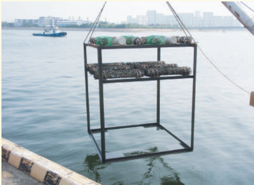
兵庫県潮芦屋ビーチに設置される人工中層海底 (JFシェルナースSF型)
