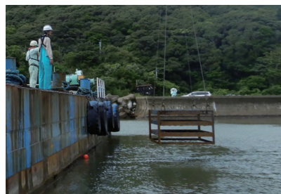
試験礁の設置
